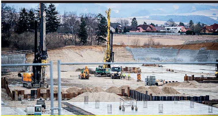
Stavenisko novej martinskej nemocnice. Foto: MZ SR
