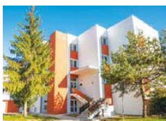
Stavebné úpravy budovy amfiteátra sociálne zariadenia a šatne pre CVČ Martin, II. etapa – zateplenie 224 748 Eur
